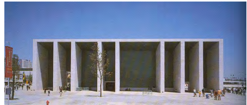
Álvaro Siza – pabellón de Portugal, 1998
