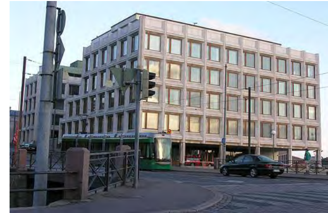
Alvar Aalto - Edificio de la sede Enso-Gutzeit, Helsinki. 1962
