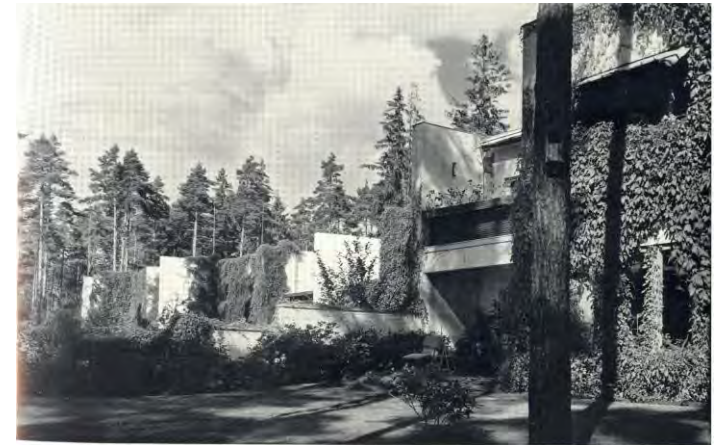
Alvar Aalto - viviendas Sunila, 1936-38
